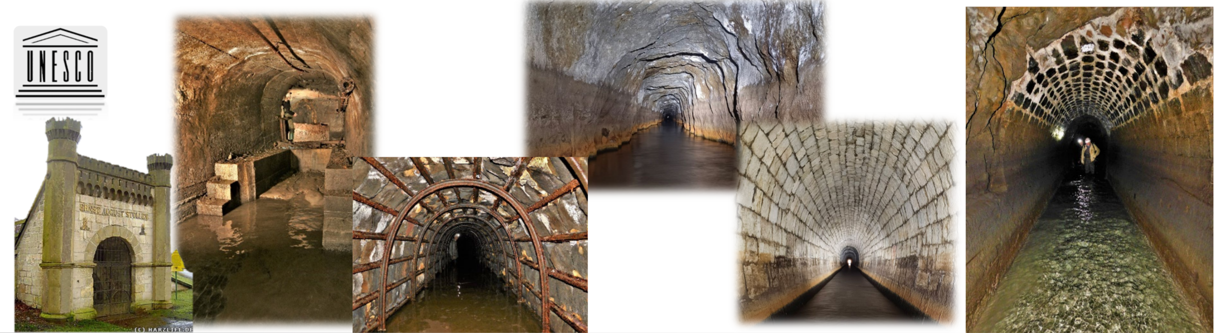
Beispielweise dieser Wasserlösungsstollen
